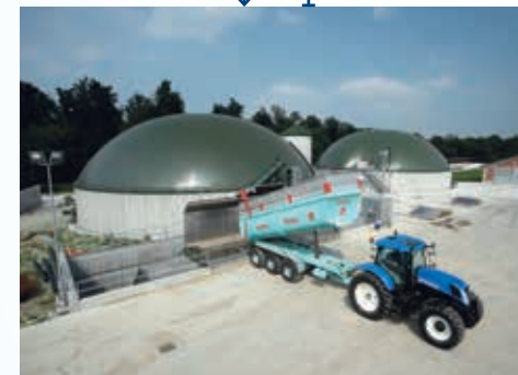
SEPTEMBRE 2010 Première ferme indépendante en énergie La ferme « La Bellotta » choisie en tant que ferme pilote indépendante en énergie
